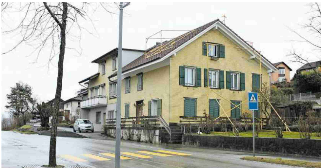
Aktuelle Bauprofile an einem Altbau in Arch.
